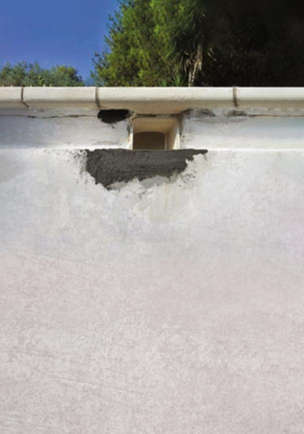
Tutti questi elementi attraversano direttamente o con alcune parti ad essi collegate la struttura della piscina e costituiscono punti critici di possibili passaggi di acqua. Proprio per questo motivo, diventa importante sigillare in modo opportuno e durevole gli alloggiamenti e le cavità predisposte per contenere tutti questi elementi, siano esse poste sul fondo della piscina, che sulle pareti verticali.
