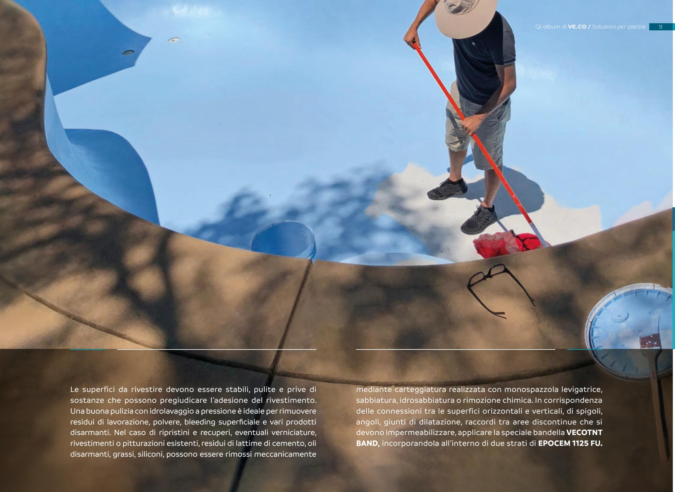
Le superfici da rivestire devono essere stabili, pulite e prive di sostanze che possono pregiudicare l'adesione del rivestimento. Una buona pulizia con idrolavaggio a pressione è ideale per rimuovere residui di lavorazione, polvere, bleeding superficiale e vari prodotti disarmanti. Nel caso di ripristini e recuperi, eventuali verniciature, rivestimenti o pitturazioni esistenti, residui di lattime di cemento, oli disarmanti, grassi, siliconi, possono essere rimossi meccanicamente
